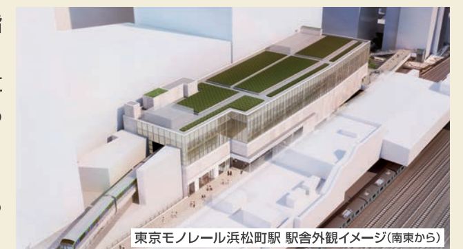
東京モノレール浜松町駅 駅舎外観イメージ(北東から)
